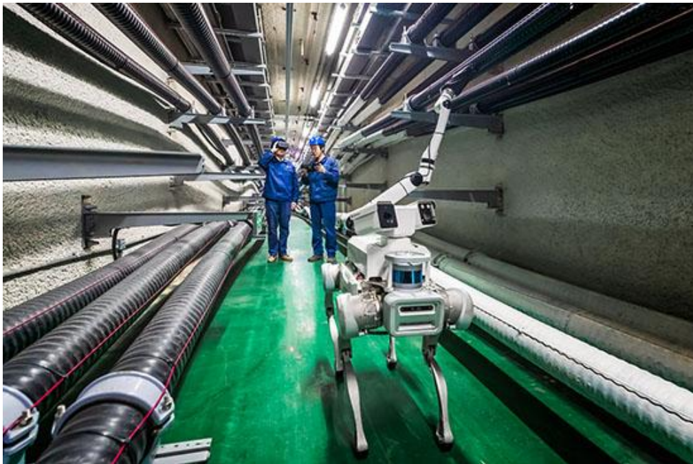
杭州市亚运村地下电力管廊巡检
